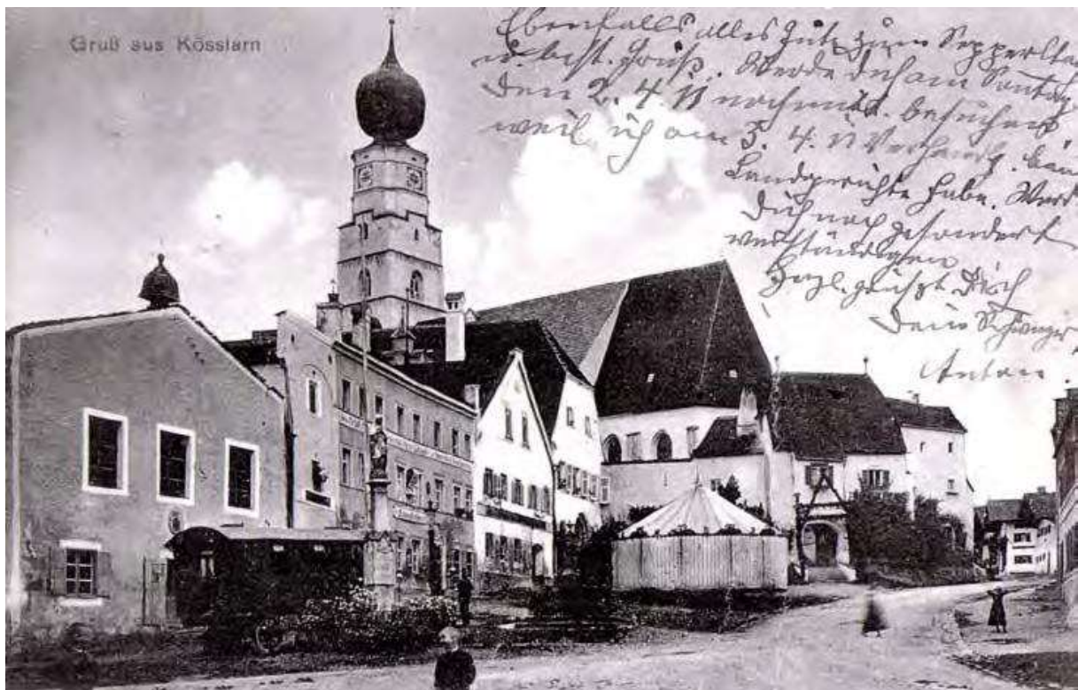
Kriegerdenkmal für 1866/1870, Granitpfeiler auf sechseckigem, gestuftem Sockel mit Maßwerkaufsatz und Muttergottes aus Gusseisen, neugotisch, nach 1870.
