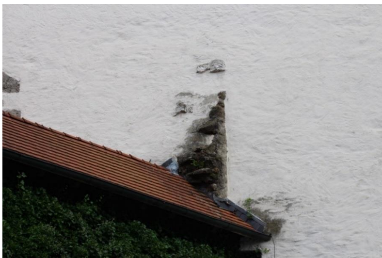
Reste der hohen Ringmauer
