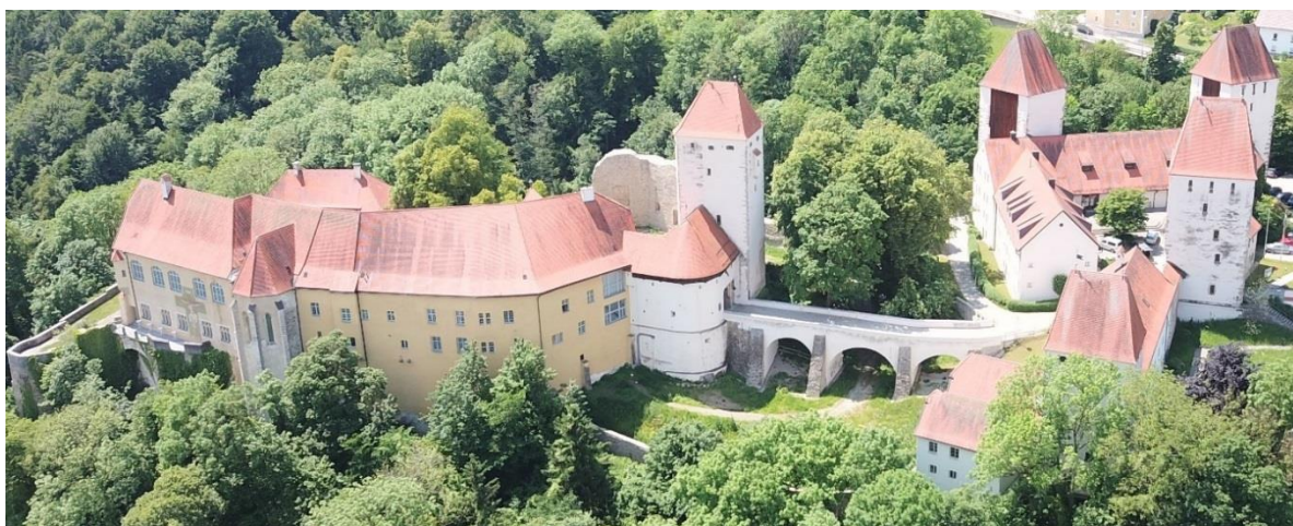
nach der Restaurierung der Brücke, Juni 2019
