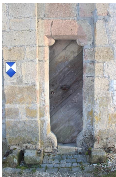
Fußgängertor der Vorburg, unten links Scharnier für die große Zugbrücke (Karrentor), rechts Scharnier für die kleine Zugbrücke (Fußgängertor), 2020
