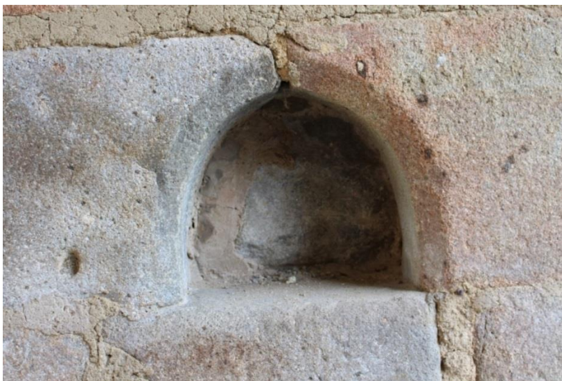
Maueraussparung für den Kienspan im Torturm als Nachtbeleuchtung für den Wächter
